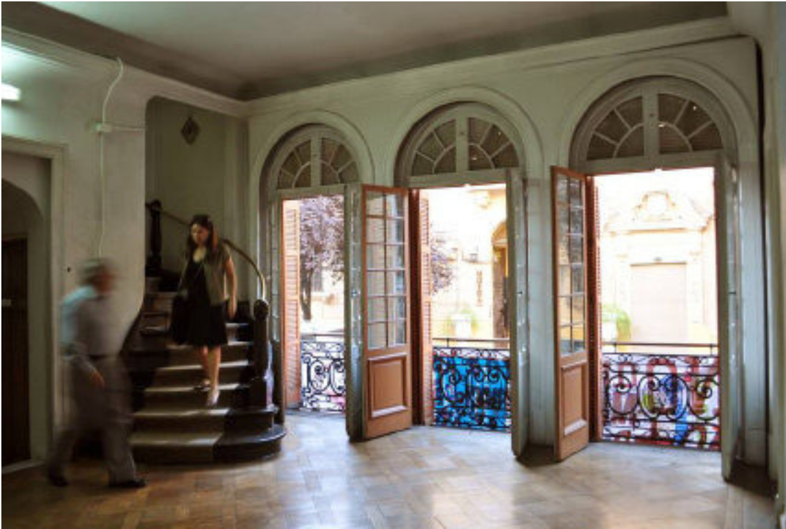
Imagen del primer piso, espacio que comunica con exterior (calle Londres)
